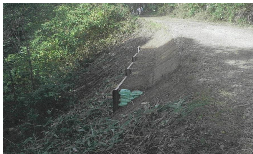
林道法面土留工事 後
