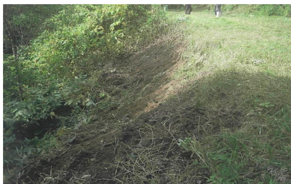
林道法面土留工事 前
