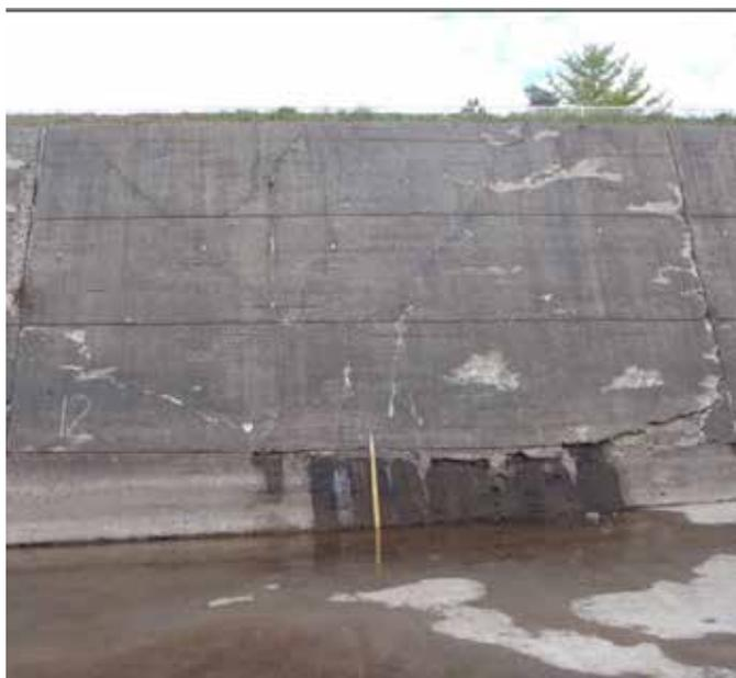
コンクリートの損傷が著しい余水吐東側面
