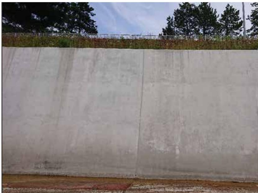
コンクリート補修の終了した余水吐東側面
