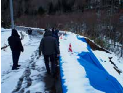
土砂崩れ現場の確認
