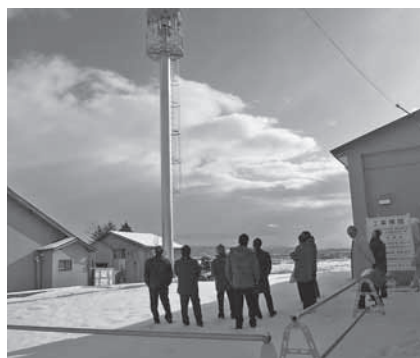
【第2分団詰所改修工事】
