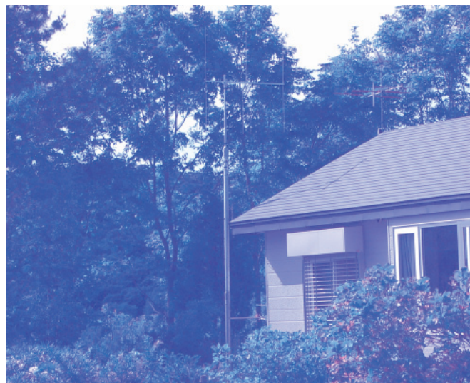
*2:3素子の八木アンテナの設置例
